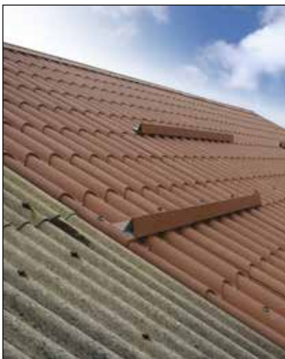
Sostituzione con pannelli
